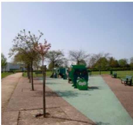
Démontage des jeux usagés pour la sécurité de nos enfants
